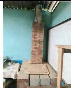
Foto 6: La estufa rural no se encuentra en funcionamiento debido al mal estado de la misma.
