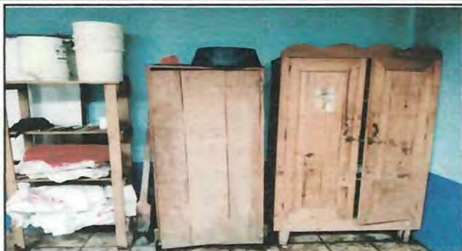
Foto 7: Los diferentes espacios con los que se cuentan para el resguardo de los utensilios de cocina, se encuentran en mal estado, con polilla. Por lo que se sustituirá por muebles de cemento
